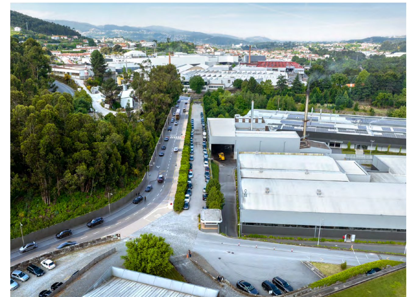
Intervenção em Vilarinho integrada no Plano Municipal de Infraestruturas. Imagem virtual do projeto
