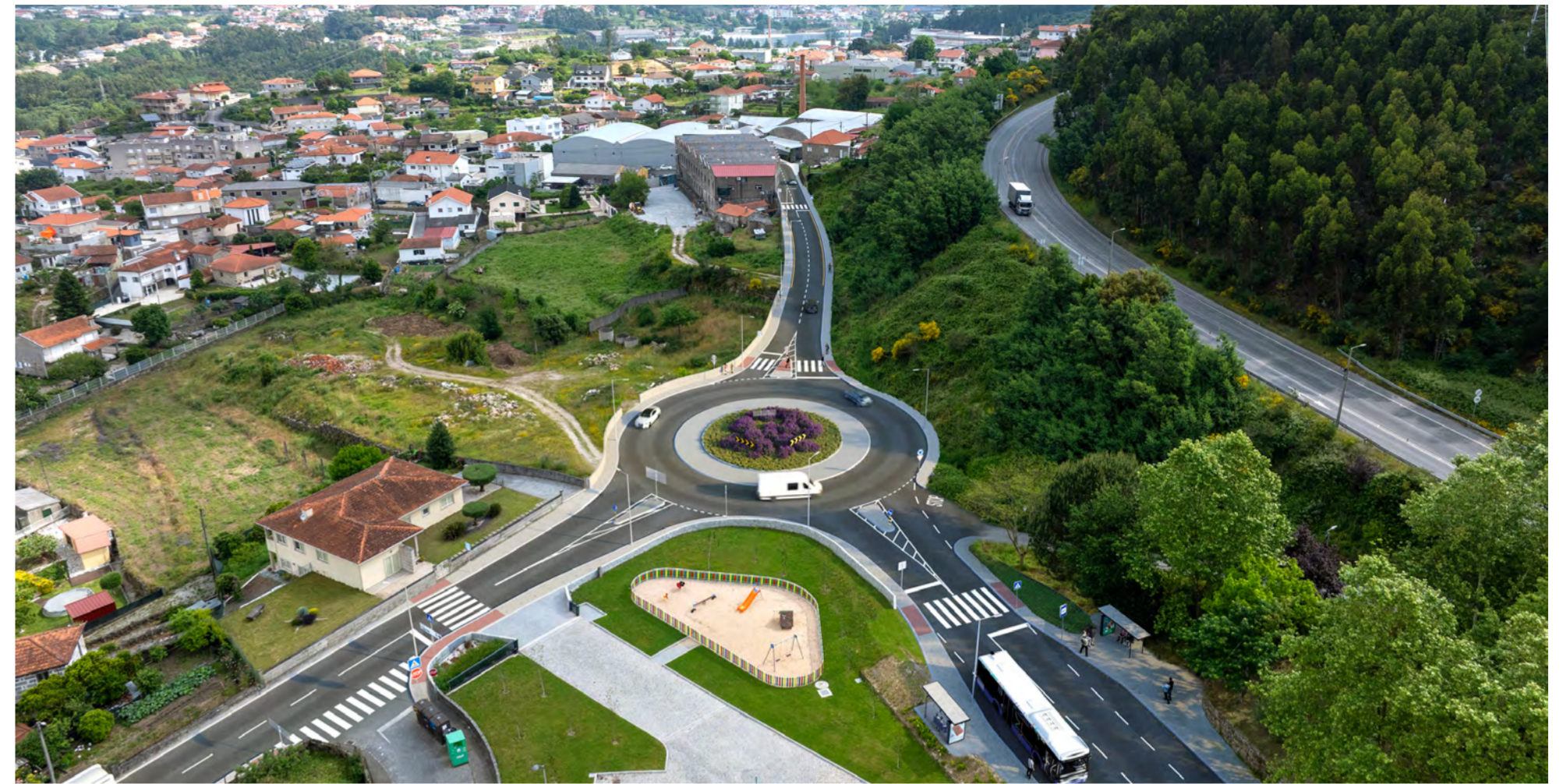
Nova rotunda na Rua das Laginhas vai melhorar as condições de circulação e segurança. Imagem virtual do projeto
