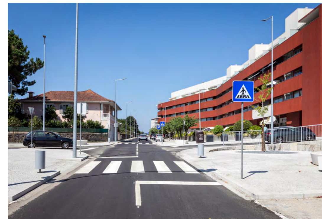
Rua João Bento Padilha foi completamente modernizada
