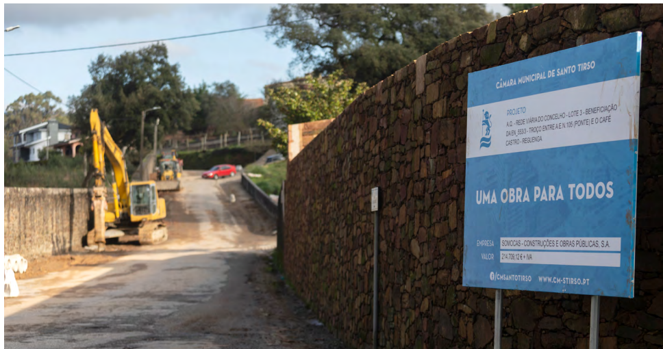
Mais uma obra para todos, desta vez na freguesia da Reguenga
