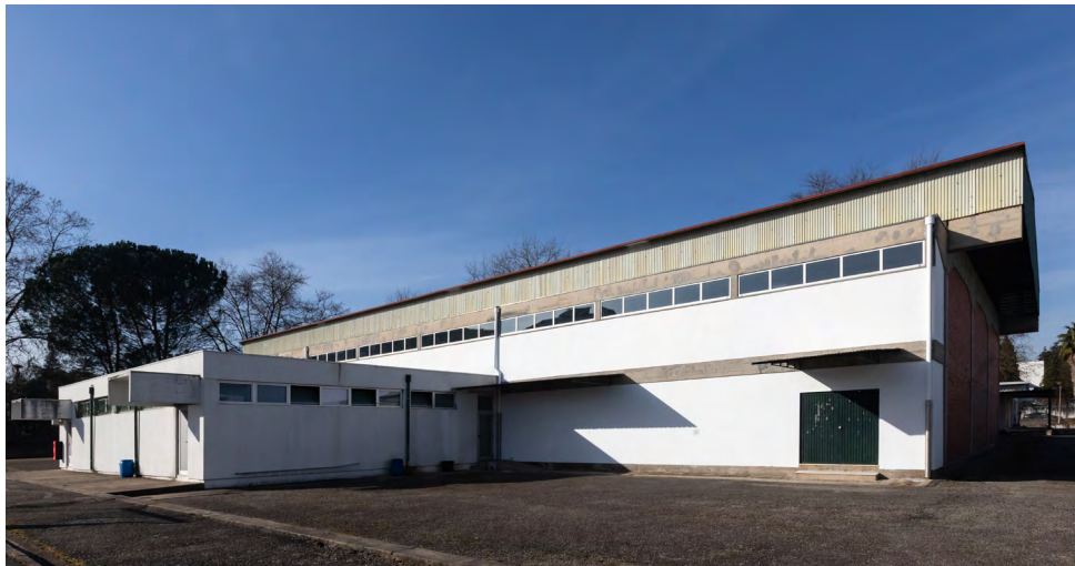
A beneficiação do pavilhão da EB de Santo Tirso está concluída
