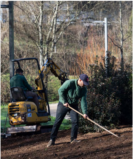
Trabalhos para a instalação da nova rega
