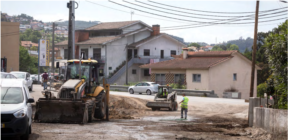
A construção da nova rotunda segue em bom ritmo
