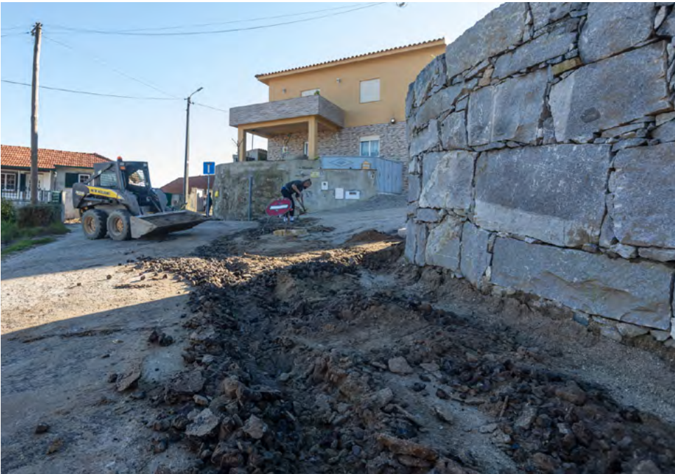
Os trabalhos na Rua Nova de Cartomil estavam, em dezembro, na sua fase final
