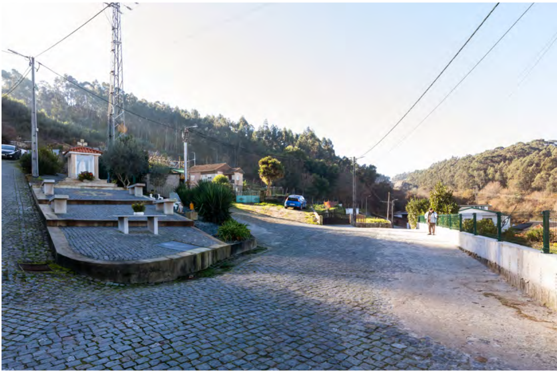
Além da pavimentação, a obra na Rua do Plaino visou o seu alargamento
