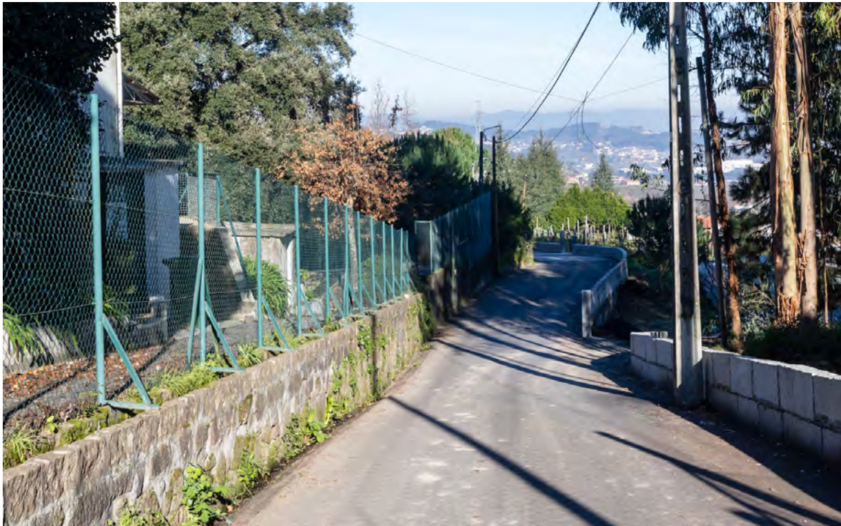
A reabilitação da Rua do Outeiro foi concluída em 2023
