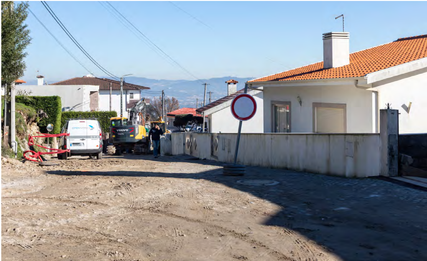
A intervenção na Rua da Coutada vai melhorar as condições desta via
